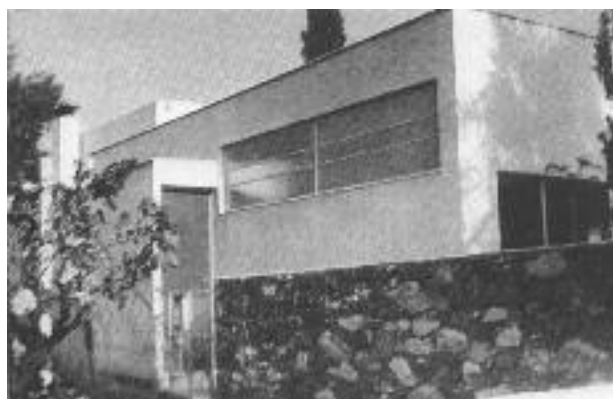
Fig. 1. Eileen Gray, Tempe à Pailla, door to the main entrance.
